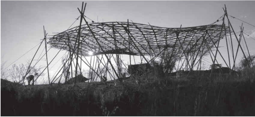
▲ Baustellenfoto und Innen- raum
