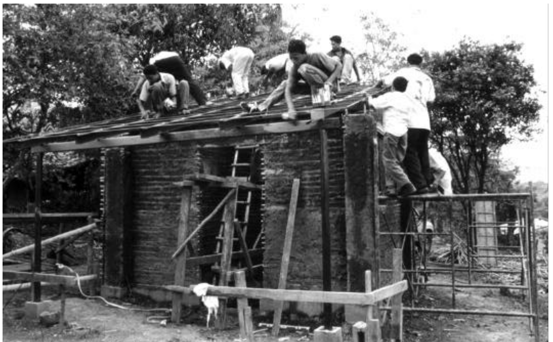
Selbsthilfe beim Bau eines Hauses in Baharequebauweise Foto: W. Carazas
