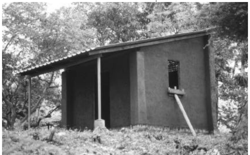
Grundeinheit (1 Raum) des erweiterbaren Hauses in Adobebauweise Foto: W. Carazas
