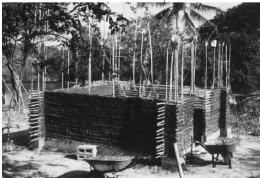
Struktur der erdbebensicheren Baharequebauweise Foto: W. Carazas
