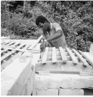
Vor Ort produzierte Zement-Ziegel wurden für den Bau der Zisterne eingesetzt.
