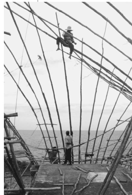
Dachkonstruktion mit Palmblattdeckung
