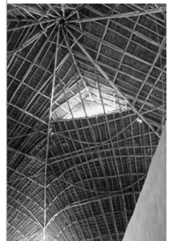
Dachkonstruktion des Inselzentrums
