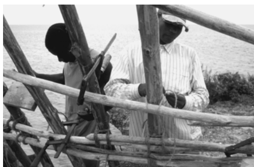
Konstruktive Verbindung mit Kokosnusssseilen
