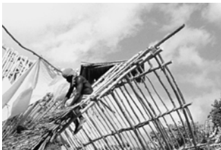
Dachdeckung mit Makuti-Schindeln
