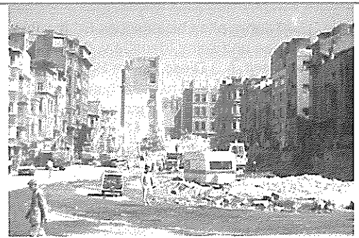
Straßendurchbruch durch den historischen Stadtteil Tariabaşı (Arin 1988)
