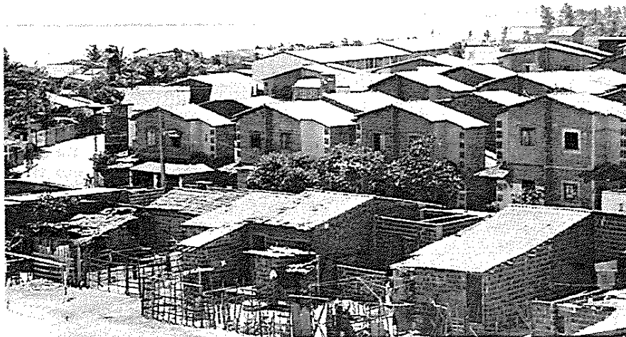
Die fertiggestellten Häuser Planalto das Goiabeiras
