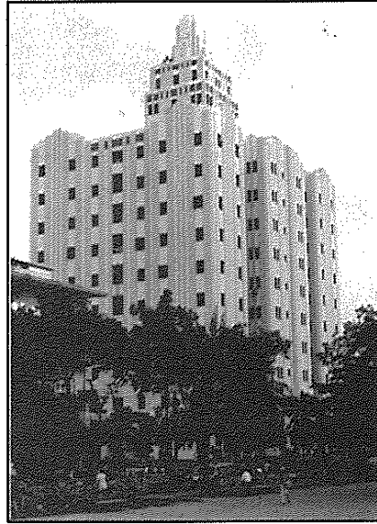
Abb. 8: Edificio López Serrano. 1932
