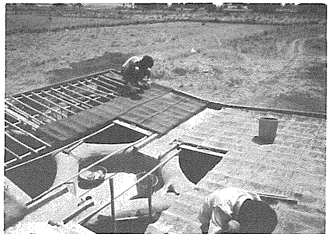
Verlegen und Festbinden der Jutebahnen.
