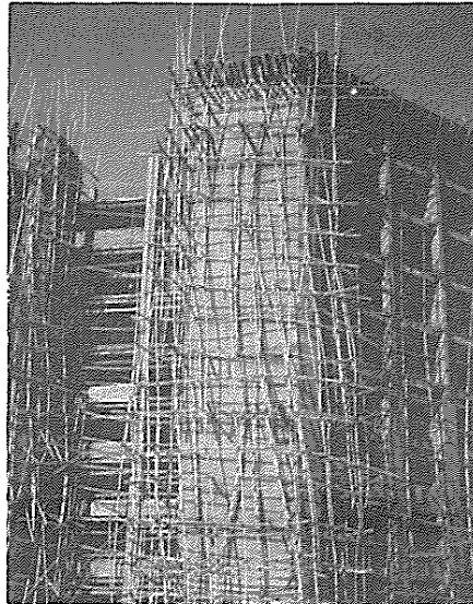
Gerüst aus Bambus in Bangla Desh
