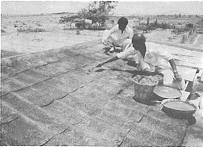
Bestreichen der Oberfläche mit Zementmörtel
