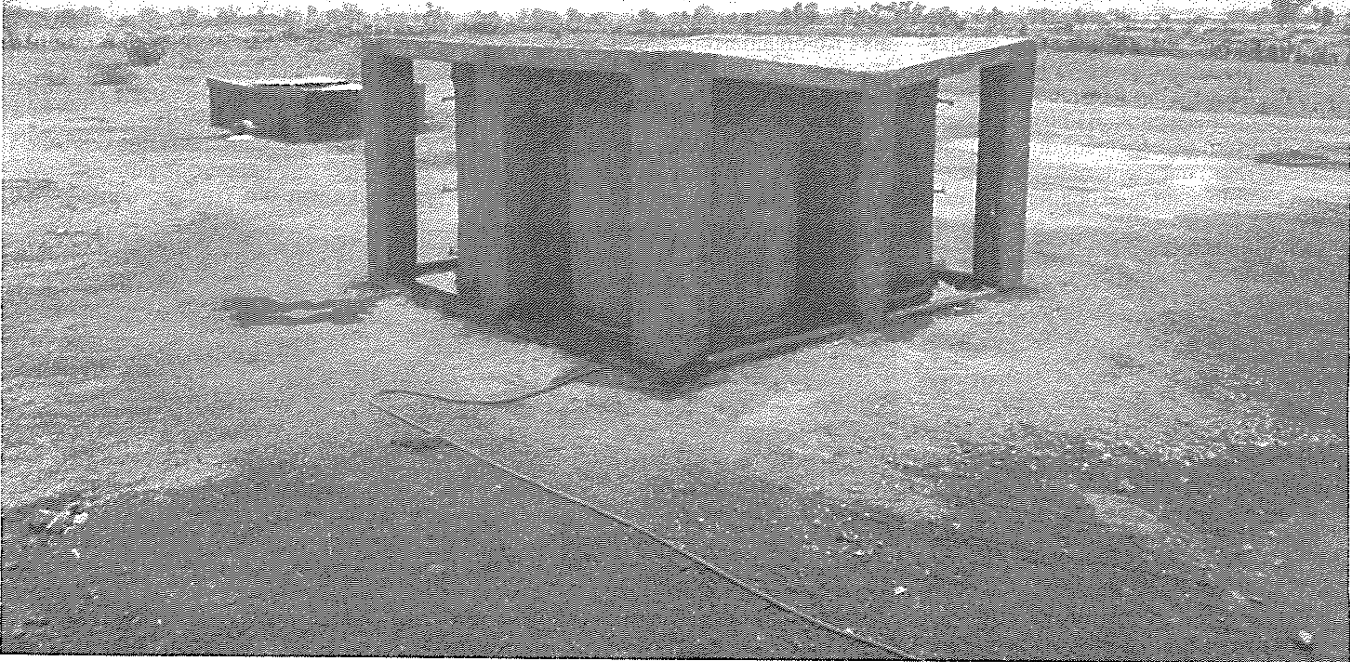
Die fertigen Regenwasser-Sammeltanks in Nasik / Indien
