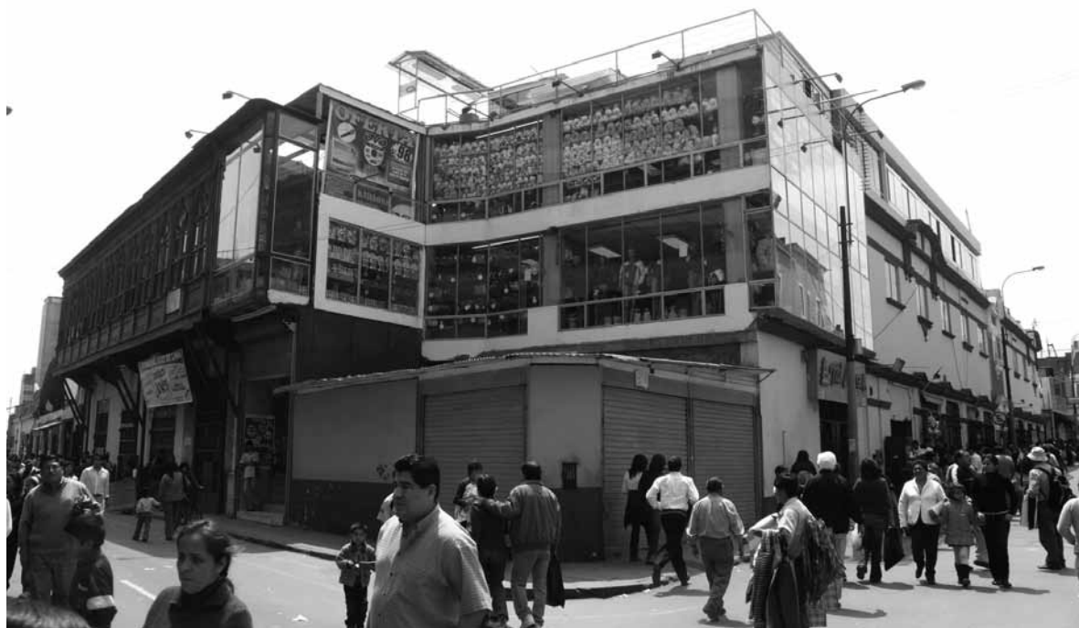
Figura 10: Nuevamente sobreconstruido con un primer piso de una galería informal (2008) Fuente: Kathrin Golda-Pongratz
