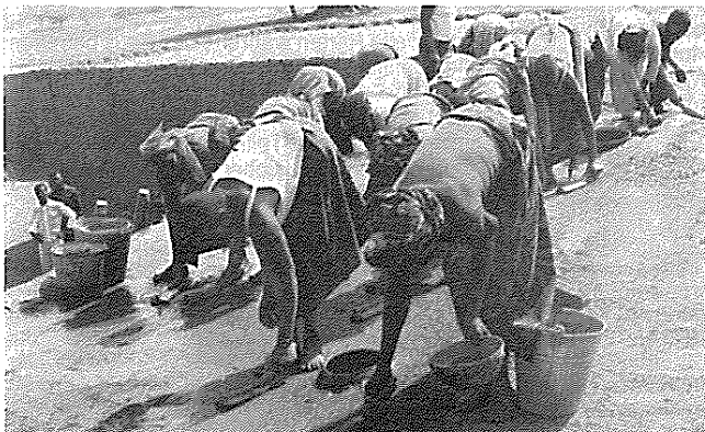
Kollektive Selbsthilfe: Frauen bei Lehmverputzarbeiten auf einem Dach; (Foto: D. Obermeier)
