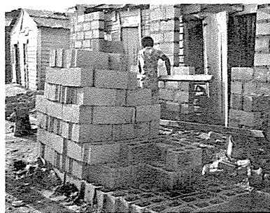
Hausbau in El Caliche (finanziert durch Kleinkredite der SODECA; die Blocksteine stammen aus der Fabrik von SODECA; die neuen Wände werden vor dem zunächst noch stehengelassenen hölzernen Altbau hochgezogen)
