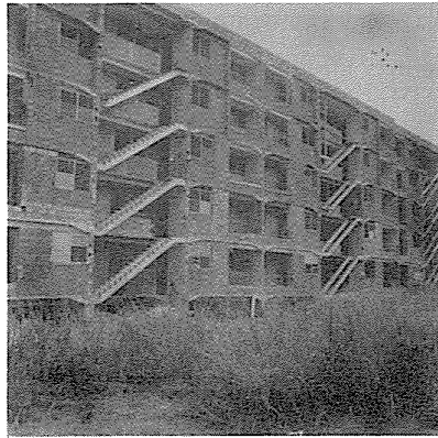
Von Mikrobrigaden erstellte Wohnbauten in Mischbauweise - in Alamar.
