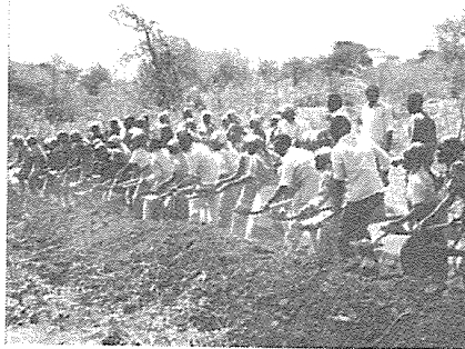
"...problem-orientierte Ausbildung: arbeitsintensive Technologien..." (Foto: "Harambee" zum Straßenbau in Kenya)
