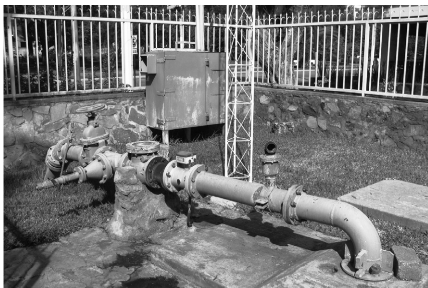
Abbildung 1: Pumpanlage zur Grundwasserförderung in Chapalita
