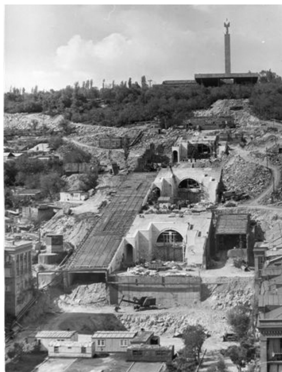
◀ Abbildung 3: Die Kaskade im Baustellenzustand, Foto: Cafesjian Center for the Arts
