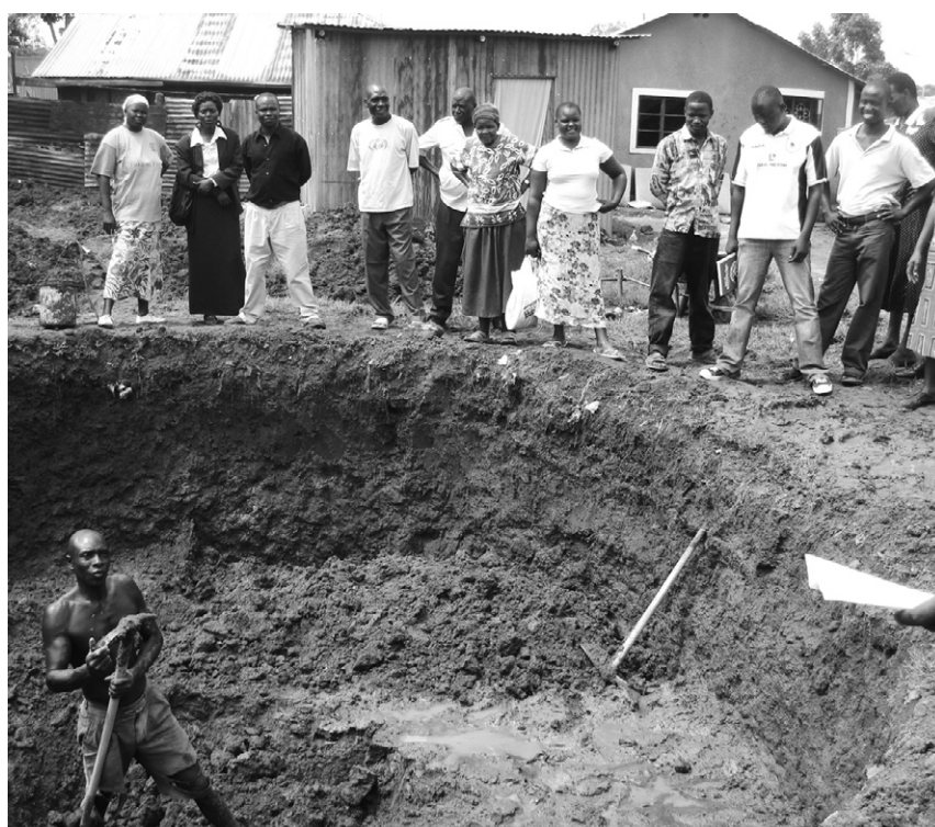
Abbildung 3: Aushub der Faulgrube für eine gemeinschaftliche Toilettenanlage der Obunga Neighbourhood Association in Kisumu, Kenia. Foto: K.Teschner, Misereor, 2010
