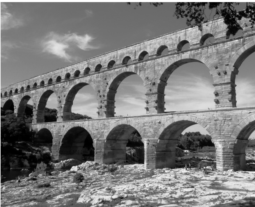
Abbildung 1: Die Aquäduktbrücke "Pont du Gard" wurde von den Römern im 1. Jahrhundert n. Chr. erbaut. Sie war Teil eines ca. 50 km langen Aquädukts, das die Stadt Nîmes mit ca. 20.000 m 3 Wasser pro Tag versorgte. Photo: Thierry
