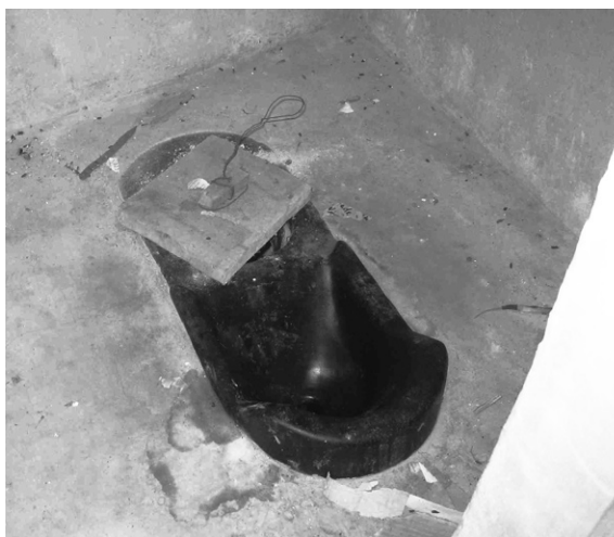
◀ Abbildung 7: Einfacher Kunststoffaufsatz zur Umrüstung herkömmlicher Latrinen zu (Steh-) Toiletten mit Urinseparation, Gitega, Kigali
