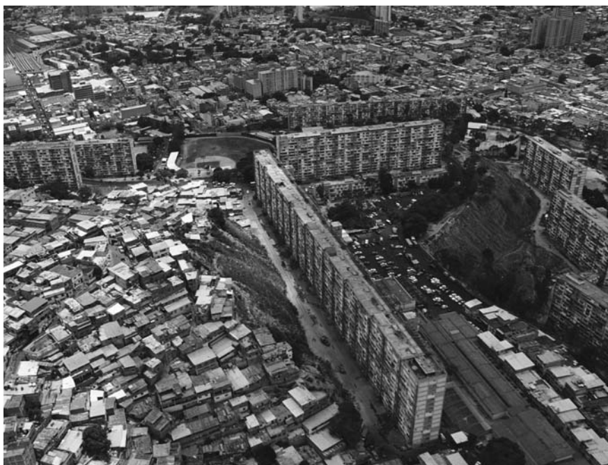
► fig. 5.: Die informell besetzten und verwalteten ‚Superblöcke‘ des venezolanischen Architekten Carlos de Villanueva "Enero 23" in Caracas stehen gleichzeitig für die Ambivalenz der gescheiterten ‚Moderne‘ und der Dynamik der Selbstorganisation. (Foto: Sabine Bitter, Helmut Weber aus der Serie Caracas, Hecho en Venezuela, 2003; vgl. www.lot.at)
