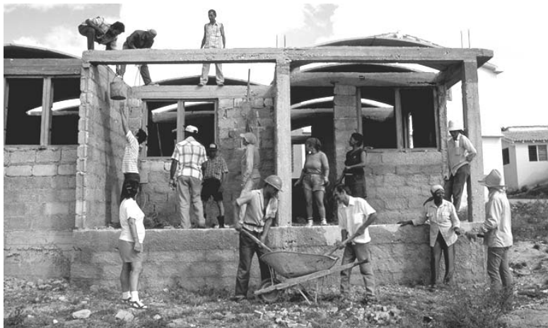
► Bau von Geschossdecken mit „Kasseler Kappen“. Foto: Katja Mand
