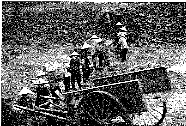
Abb. 3 / Bauarbeiterinnen, Straßenerweiterung am Highway Hanoi-Halphong
