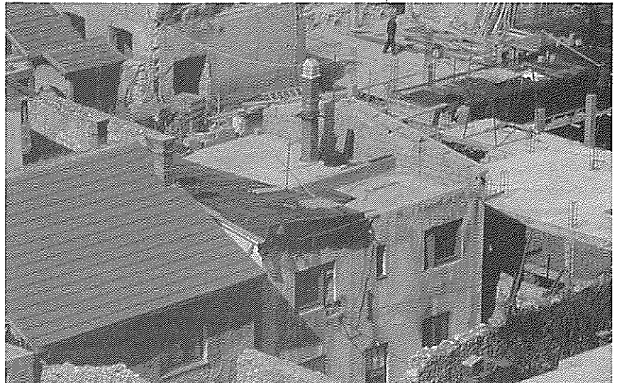
Links repariertes Dach, mitte Notdach mit roter PVC-Folie, rechts weitere Bautätigkeiten
