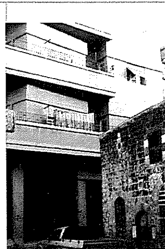
Abb. 13 / Umbau traditioneller Hofhausstrukturen in eine dreigeschossige Blockrandbebauung in der Altstadt von Homs
