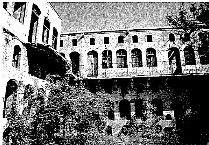
Abb. 7 / Ende des 19. Jahrhunderts erbautes mehrgeschossiges Stadthaus in der Altstadt von Aleppo
