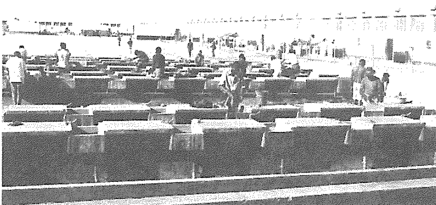
Compound in Walvis Bay: Massenquartier für Wanderarbeiter (Foto: J. Kotowski-Ziss)
