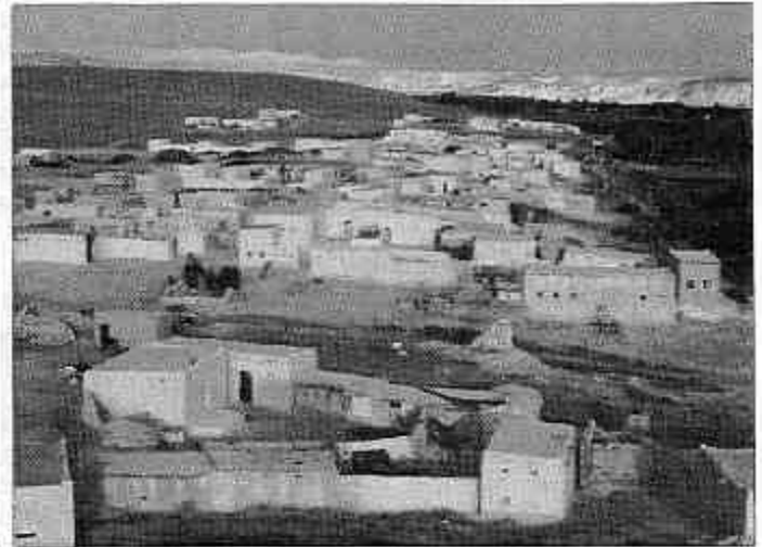
Ein Dorf im Euphrattal. Die Haupthäuser der Gehöfte haben vorwiegend jenen Mittelbalkengrundriß, der innen in drei einzelne Bereiche untergliedert ist. Das Haus im Mittelgrund rechts außen ist bislang das einzige Betonfertigsteinhaus des Dorfes; es handelt sich um ein Rechteckhaus mit deutlich größeren Fenstern.
