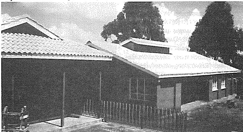
*Ein Beispiel angepaßter Technologie in Kenya. Schulgebäude aus Erdzementsteinen mit Sisalfaserzement-Dachdeckung - Earth blocks and sisal fibre roof sheets*
