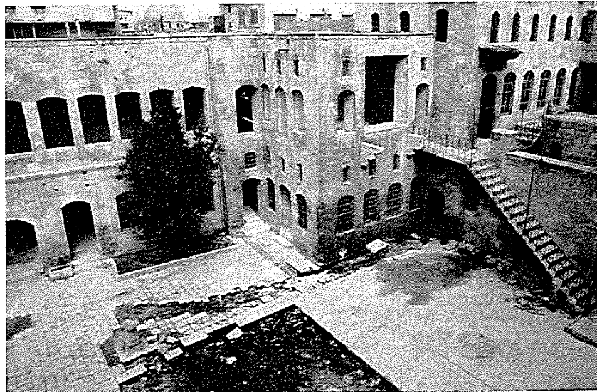
Abb 7: Nordostteil der "Madrasa", Hof I, während der Restaurierungsarbeiten, Juli 93
