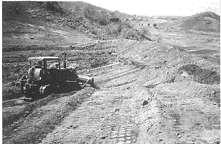
Geordneter Einbau des Abfalls in der Deponie
