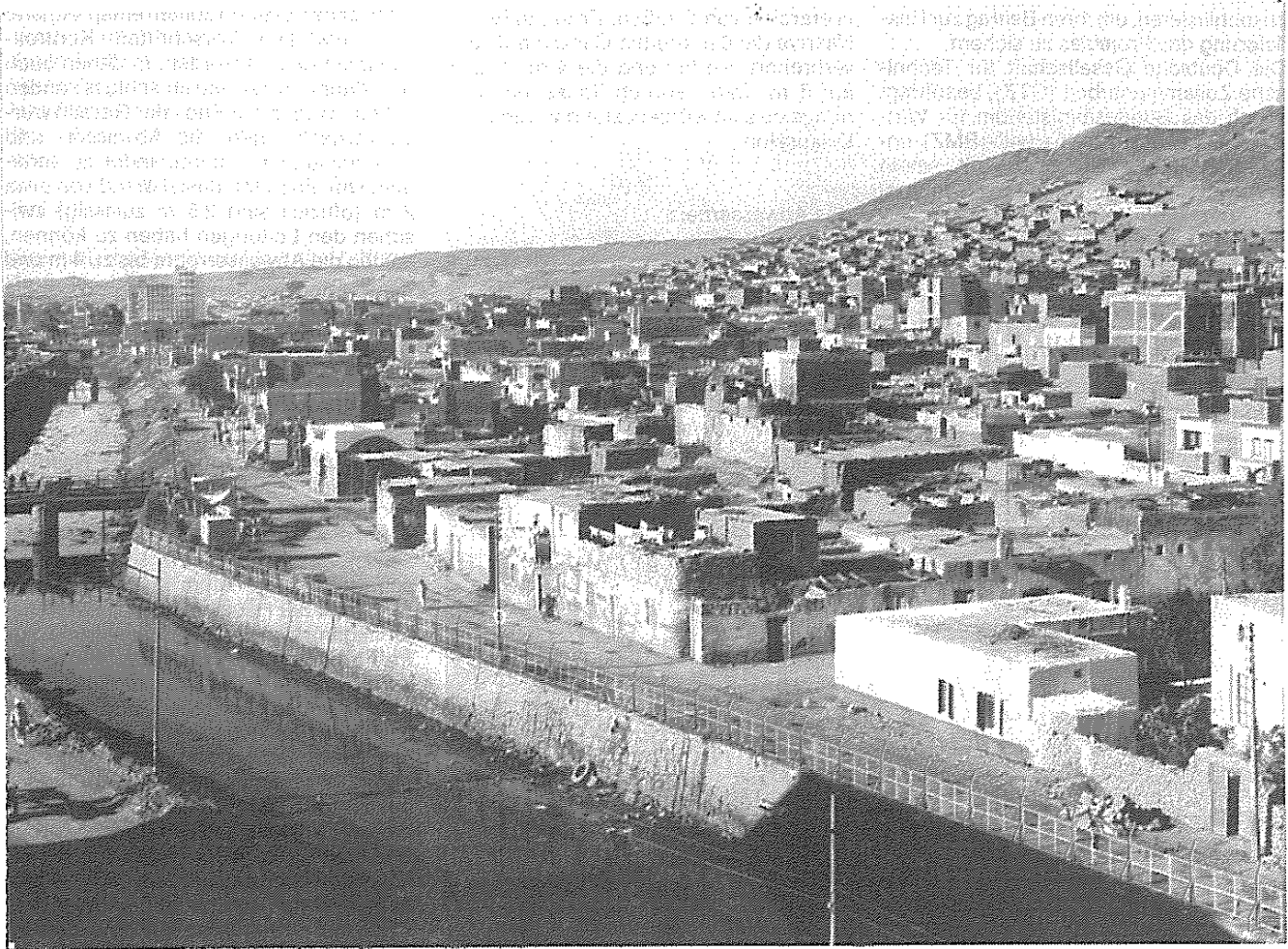
Übersicht über den nördlichen Teil von Nasriya
