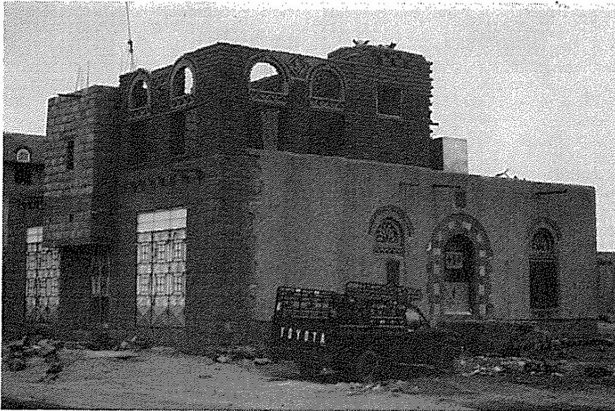
*Bild 2 — „Cocktail“-Konstruktion aus Lehm, Stahlbeton, Zement- und Natursteinen. Bauen wie seit alter Zeit — als Prozeß, aber nicht mehr nach traditionellen Regeln gesteuert, sondern offensichtlich als Aneinanderreihung willkürlicher ad-hoc-Entscheidungen.*
