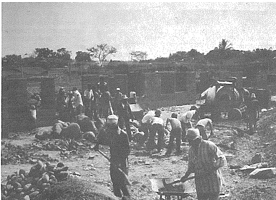
Bauen und Baustoffproduktion in einer Hand; San Pablo, Kolumbien Foto: Werner Wilkens
