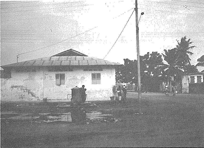
Trinkwasserversorgung über öffentliche Wasserhähnen (Cotonou, Benin)
