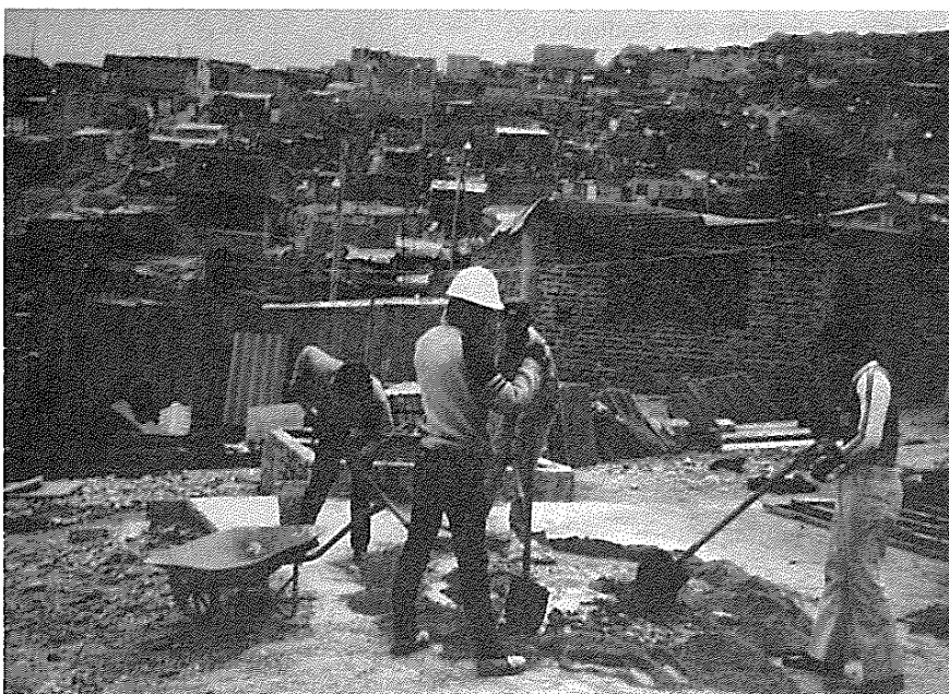
Selbstbau bedeutet noch lange nicht Bereitschaft zur Gemeinschaftsarbeit Foto: Roland Ziss
