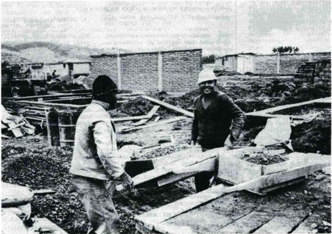
Nachbarschaftshilfe: Handtransport der Zuschlagstoffe für Beton
